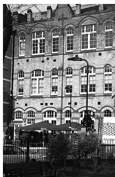
小学校を改装したレストラン、ホクストン・アプレンティス
