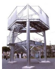
避難タワーの設置
