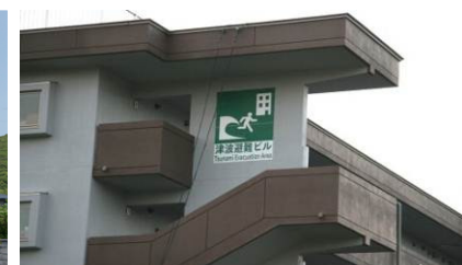
公営住宅等の屋上等の活用
