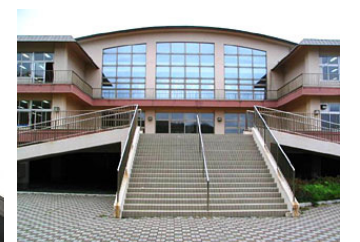
津波対策を講じた学校施設
