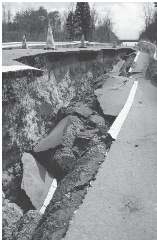
(道路の被災状況 松塚地内)
