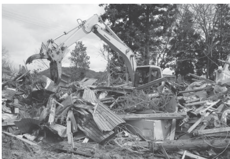
(被災現場の災害復旧 長沼滝地内)
