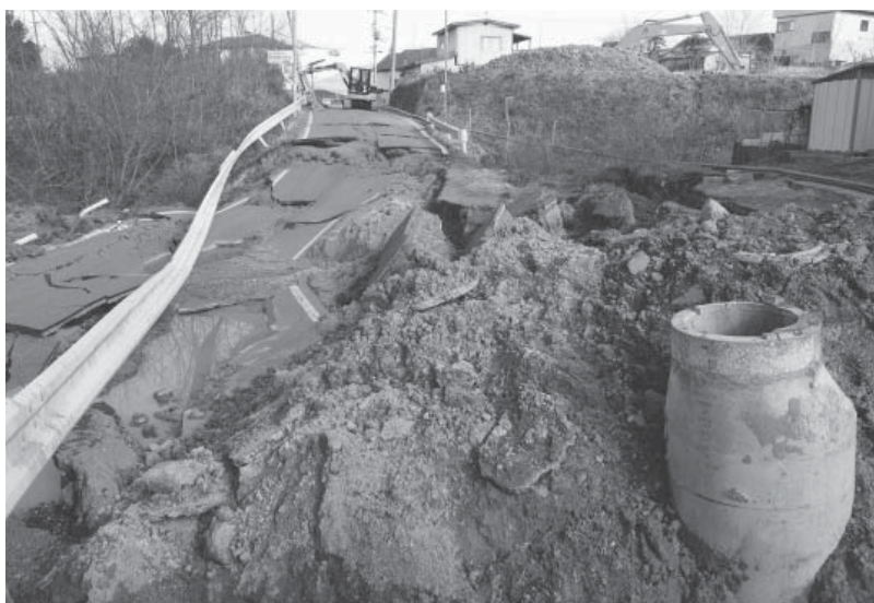
(道路の被災状況 緑町地内)
