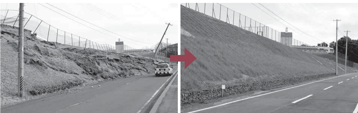
▲平成24年2月に工事を完了した東中学校北側(鷹巣側)
