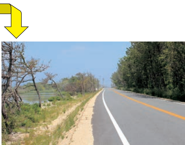
写真4-57 改修が完了した県道四倉－豊間線 〔平成24(2012)年6月 いわき市撮影〕
