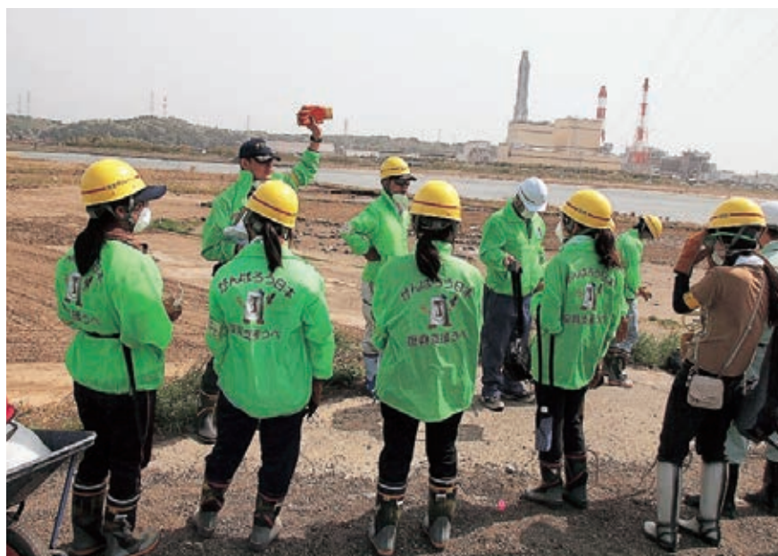
写真4-30 勿来地区災害ボランティアセンターの活動 農地のガレキ撤去も行われた。 〔5月2日 山口県宇部市提供〕
