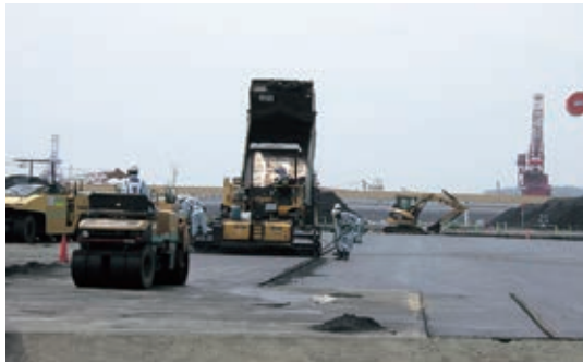
写真4-52 復旧が進む小名浜港の5・6号埠頭 〔7月25日 いわき市撮影〕
