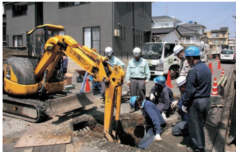
写真4-45 ガス管の修繕工事（常磐下湯長谷町）〔4月15日 常磐共同ガス㈱提供〕
