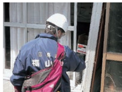
写真4-84 応援職員による、リ災家屋の調査 〔4月2日 広島県福山市提供〕
