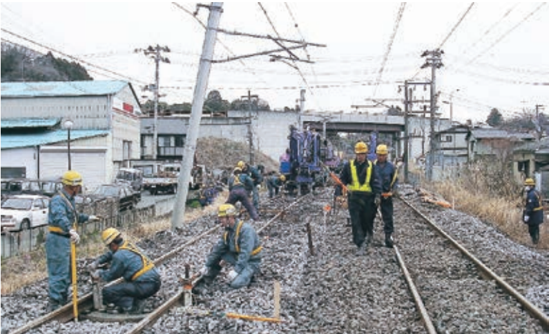
写真4-50 いわきー内郷の復旧作業 電化柱が傾斜するなど大きな被害が発生した。 〔3月18日 JR東日本(株)水戸支社提供〕
