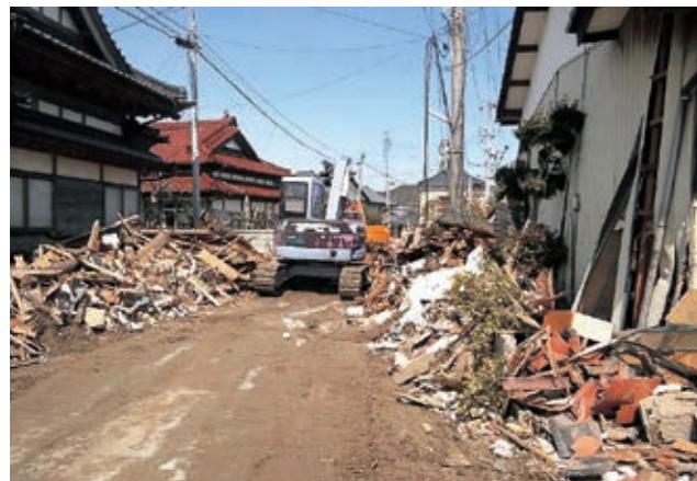
写真4-18 まず、道路通行を確保するためにガレキを除去 〔4月 いわき市撮影〕
