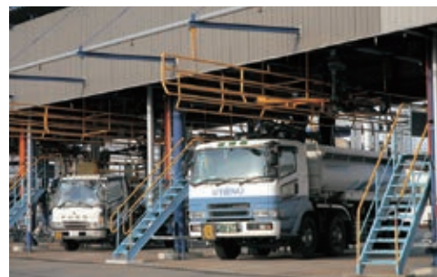
写真4-36 小名浜石油(株)のガソリンタンクから給油するタンクローリー 〔いわき市撮影〕
