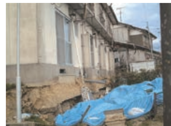
写真2-14 四倉の市営住宅梅ヶ丘団地では、敷地内の一部が崩壊 〔4月27日 いわき市撮影〕
