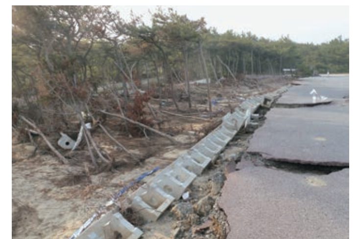
写真2-24 地震や津波で被害を受けた新舞子海岸（新舞子ビーチ付近） 〔6月3日 いわき市撮影〕
