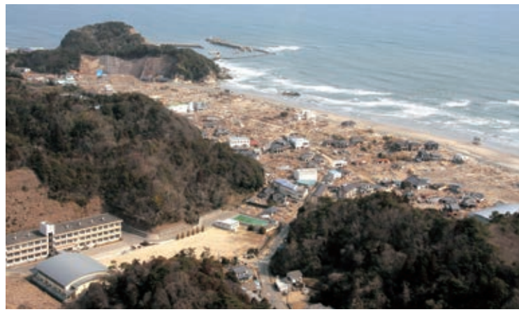
写真2-26 壊滅的な被害を受けた薄磯集落。密集していた家屋が跡形もない。写真左手前の豊間小学校は奥まった地形に位置し、難を逃れた。(3月12日 福島県消防防災航空隊提供)
