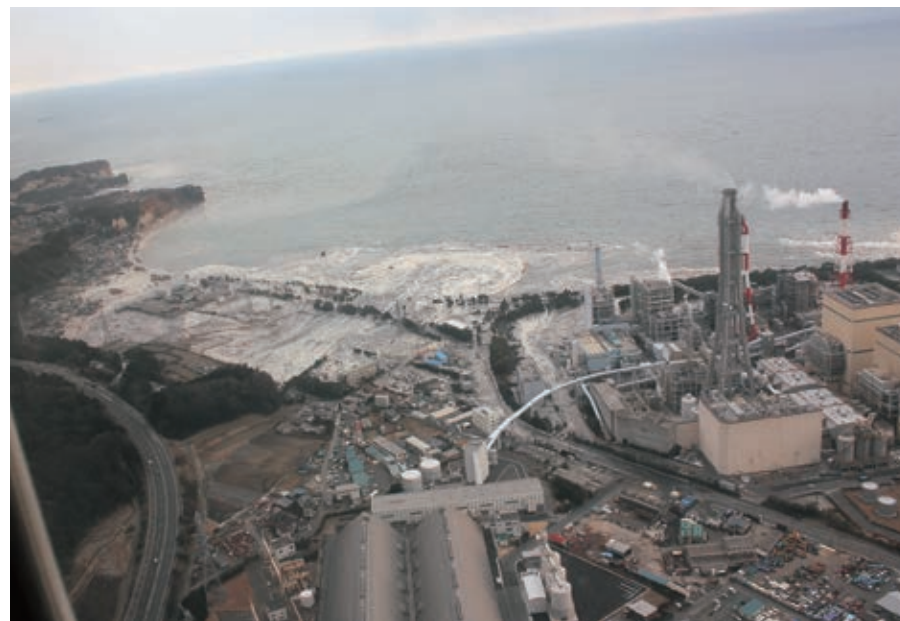
写真2-37 防波堤を破壊して岩間集落を襲う津波。写真右の発電所にも押し寄せる津波 〔3月11日午後3時46分ごろ 福島県消防防災航空隊提供〕
