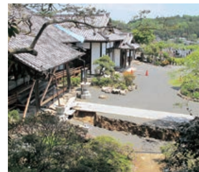
写真2-9 藤原断層の上で被災した常磐藤原町の建徳寺 〔4月14日 菅波晋氏提供〕
