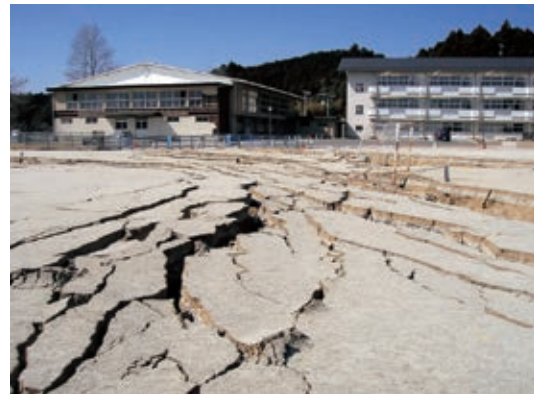
写真2-13 植田小学校校庭の地割れ 校舎のうち、教室付近の切り土を校庭に盛ったと考えられる。 〔4月6日 市教育委員会撮影〕
