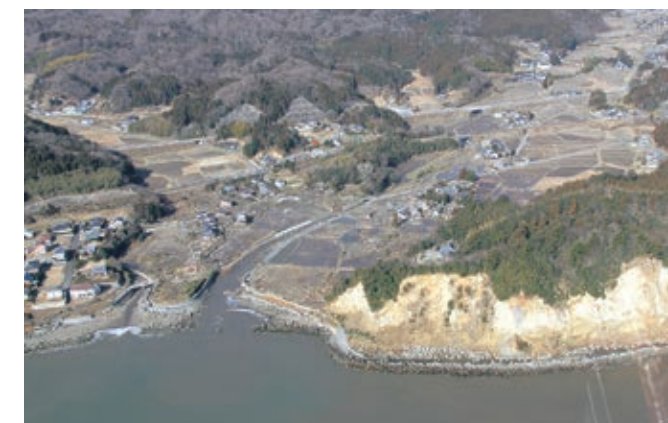
写真2-16 末続川を溯上して津波が拡大 [3月12日 福島県消防防災航空隊提供]
