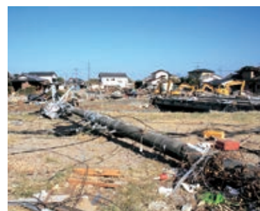
写真2-50 倒壊した電柱 〔4月5日 佐藤貴行氏提供〕
