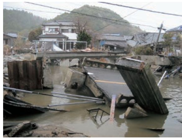
写真2-30 大平川を溯上した津波は大平橋を破壊 〔4月23日 いわき市撮影〕
