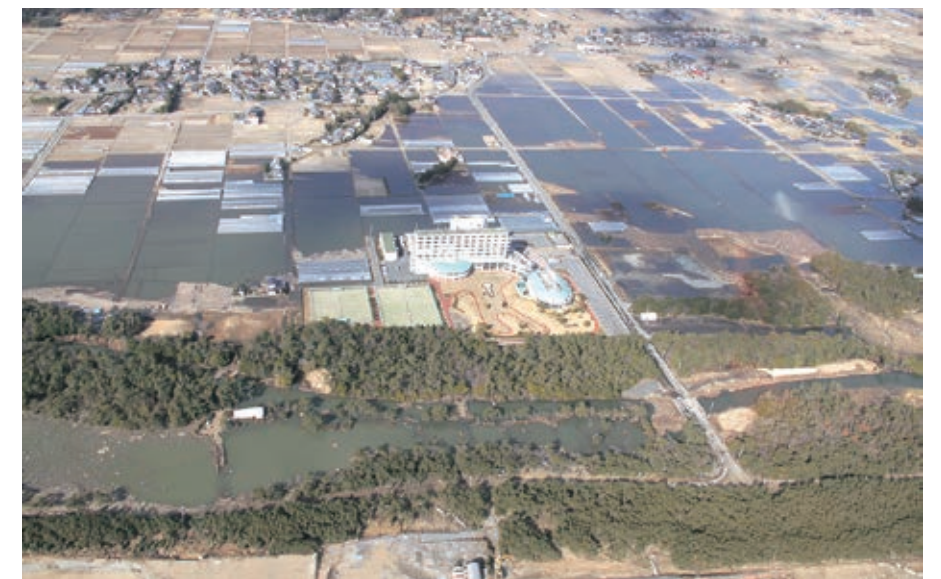
写真2-23 写真手前の防潮林に遮られ大きな被害は避けられたが、水は低地奥まで浸水 〔3月12日 福島県消防防災航空隊提供〕
