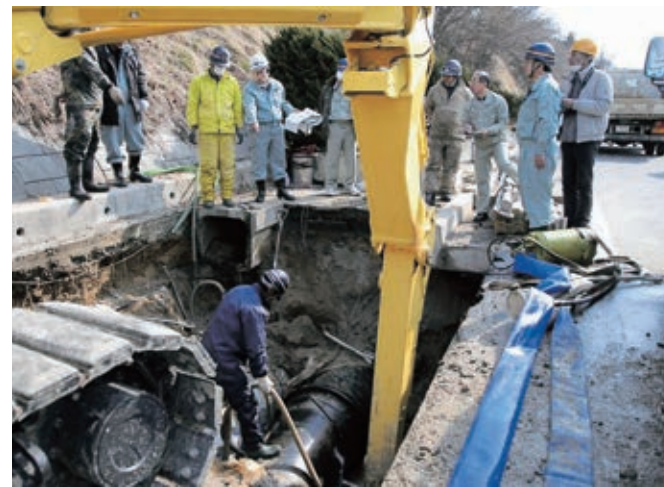
写真3-52 市外からの応援で復旧が進む上水道施設 〔3月25日 市水道局撮影〕
