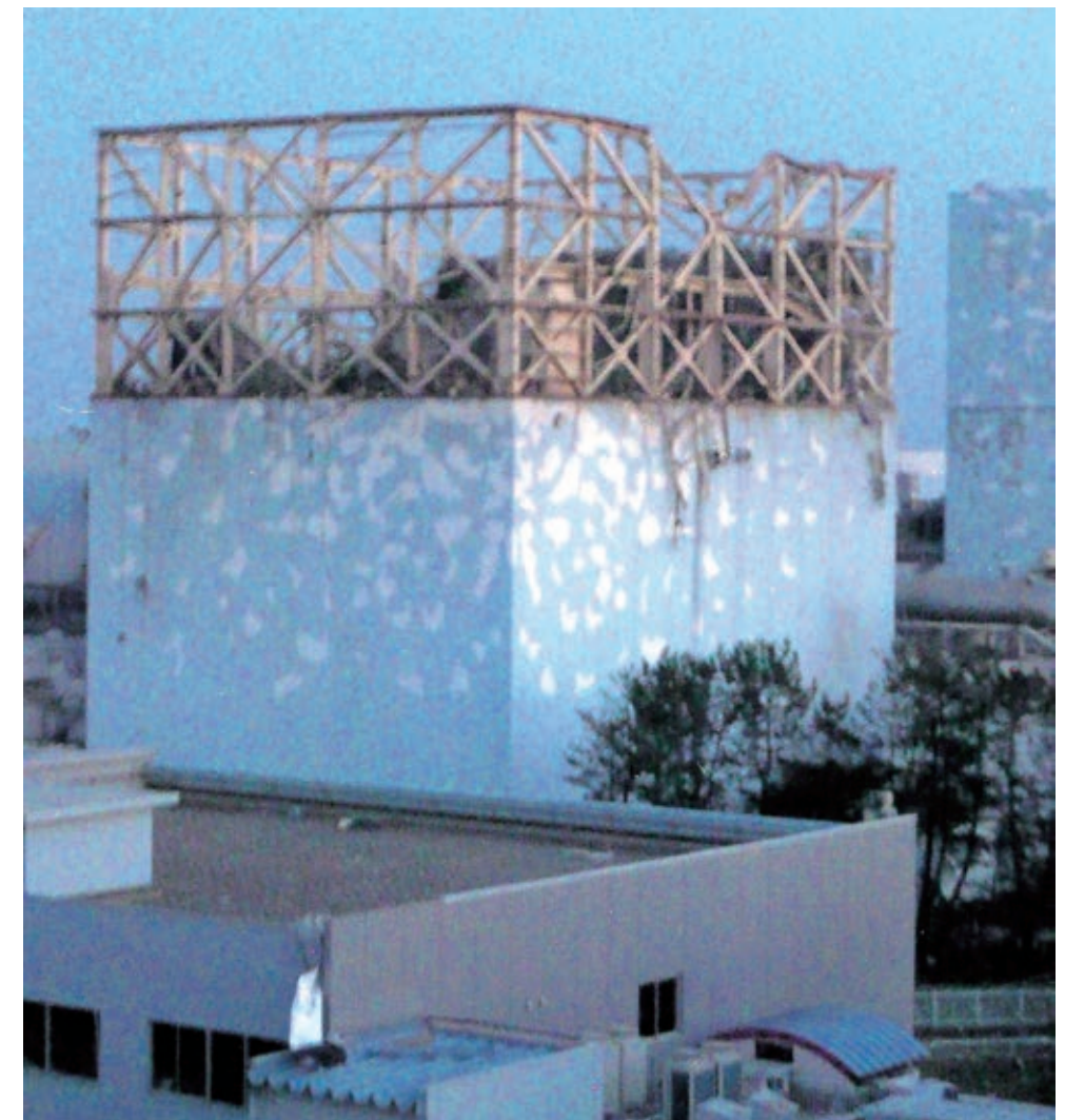
写真3-13 爆発した1号機(3月12日 東京電力(株)提供)
