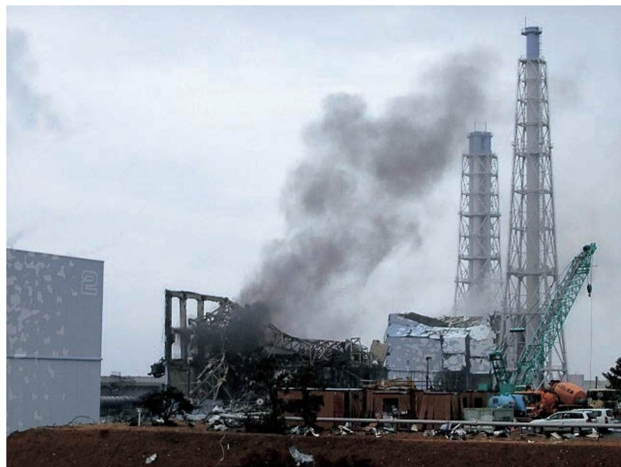
写真3-30 爆発後の3号機 (3月21日 東京電力提供)
