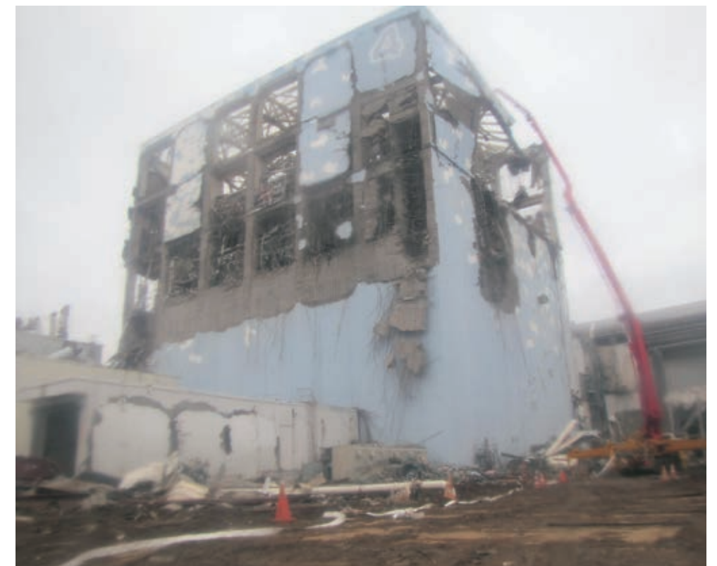
写真3-43 4号機注水車から放水 〔3月22日 東京電力(株)提供〕
