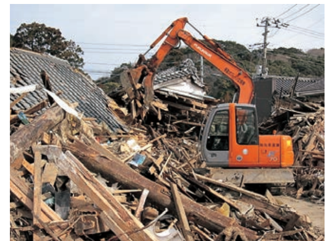
写真3-22 津波に破壊されたガレキの撤去 (3月26日 いわき市撮影)
