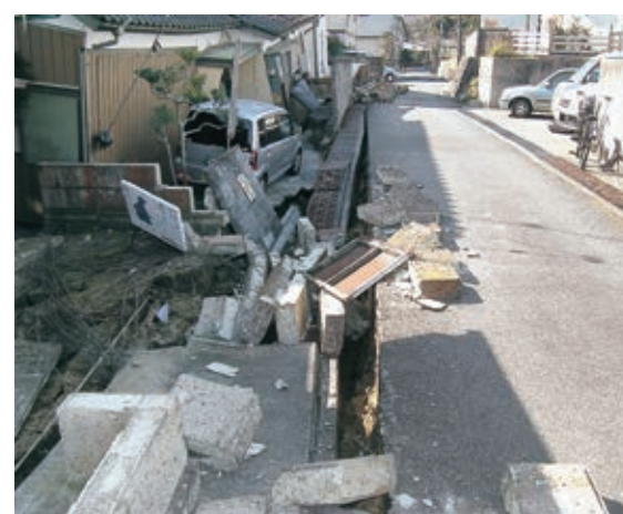
写真3-45 常磐西郷町忠多地内の被災状況〔3月12日 いわき市撮影〕
