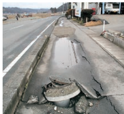
写真2-49 隆起した農業集落排水施設のマンホール 〔3月31日 いわき市撮影〕
