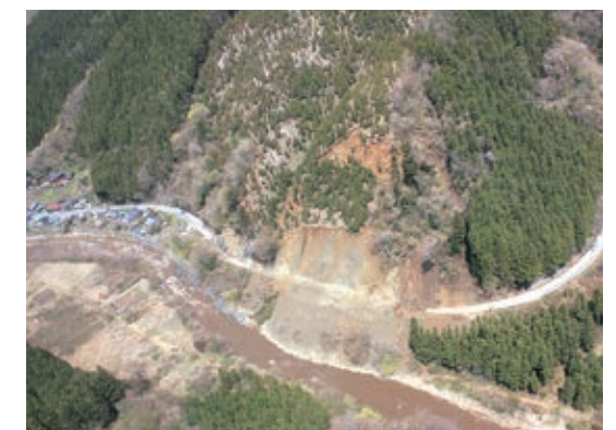
写真2-10 主要地方道いわき-石川線、田人町才鉢地内の崩落現場 〔4月 陸上自衛隊第8普通科連隊提供〕
