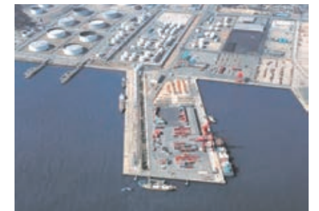
写真1-3 小名浜港外国貿易コンテナターミナル [平成21(2009)年10月 いわき市所蔵]
