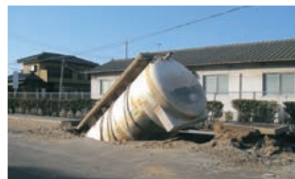
写真2-6 四倉中学校の液状化現象 〔4月6日 いわき市教育委員会事務局撮影〕
