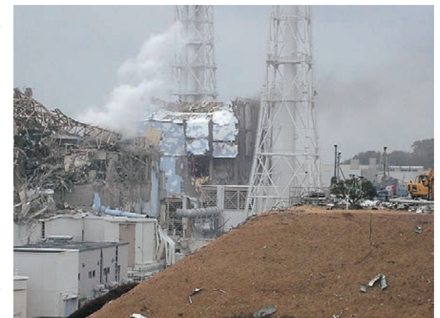
写真3-38 4号機の状況 [3月15日 東京電力㈱提供]
