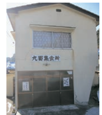
写真2-41 被災した地域集会所 九面集会所 壁面にヒビが入った。各地域で所有・管理する多くの集会所も地震や津波で破損した。 〔平成24(2012)年1月 いわき市撮影〕
